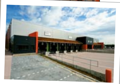
De units hebben een individuele temperatuurregeling waardoor ze ook geschikt zijn voor tijdelijke geconditioneerde opslag
